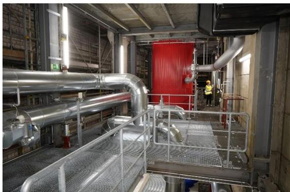
Abbildung 11 Elektrodenheizkessel Karoline in Hamburg (Wärme Hamburg GmbH, 2021)
