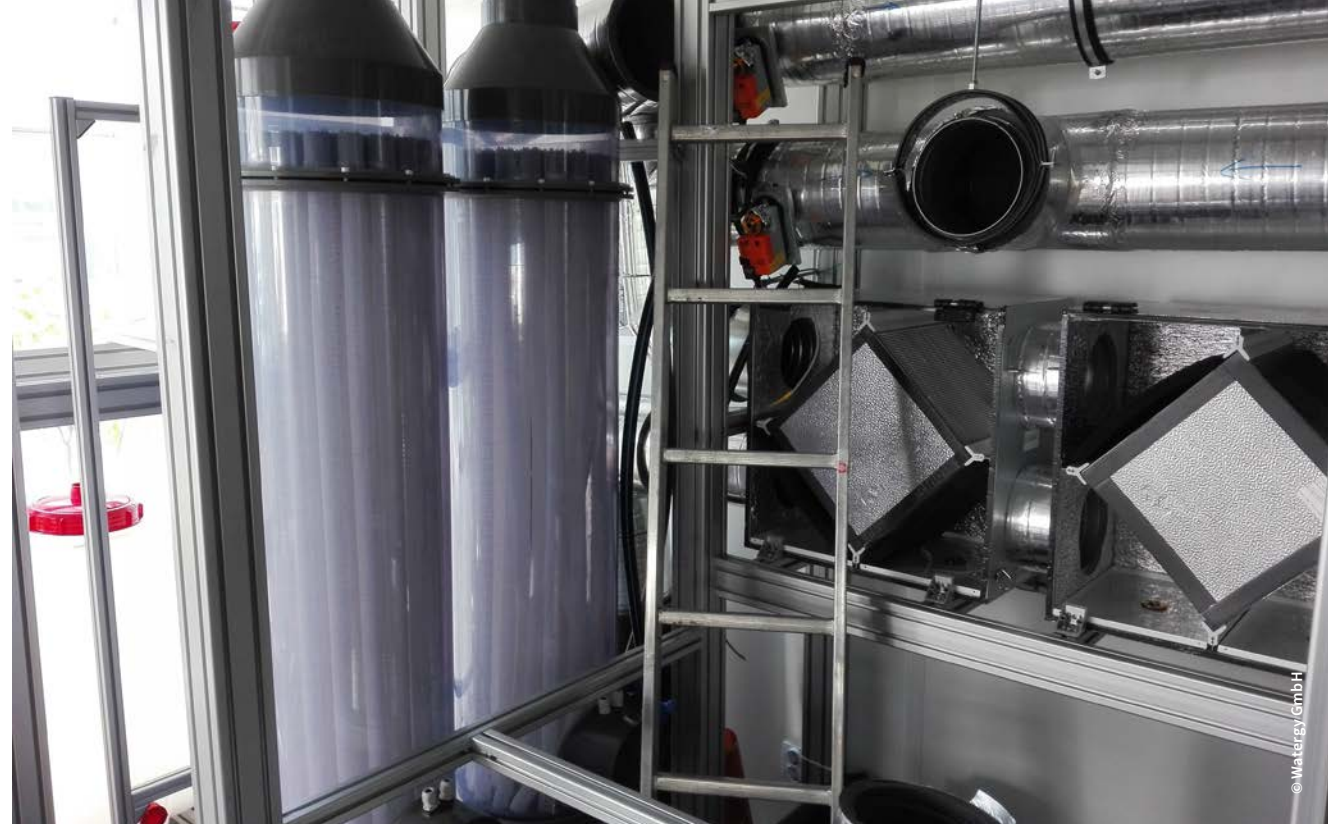
Klimagerät mit flüssiger Sorptionslösung für die Anwendungsgebiete Raumheizung, Raumkühlung, Wärmerückgewinnung, Luftfeuchteregulierung sowie Lüfthygienisierung
