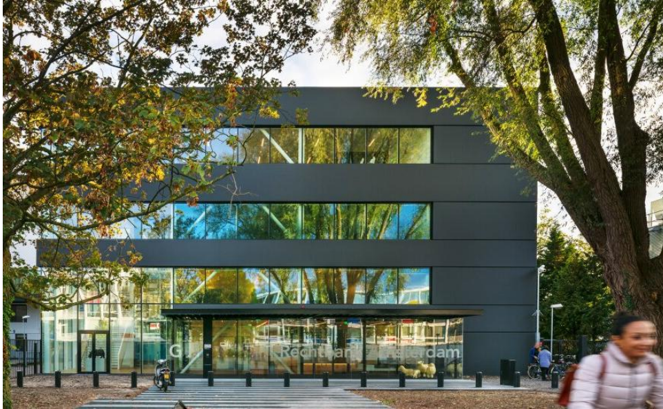
Temporäres Gerichtsgebäude in Amsterdam (2016), Abbau und Neuaufbau in Enschede 2023
