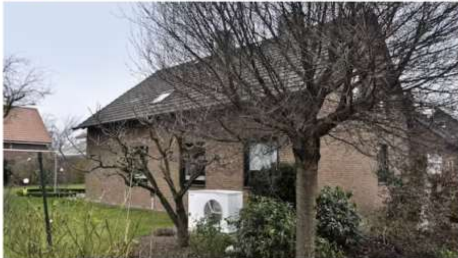
Schornsteinfeger übersetzt neues Heizungsgesetz. Das sollten Sie wissen Bundesverband Wärmepumpe e.V.
