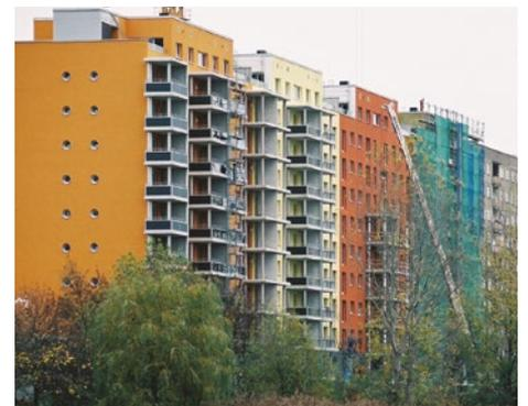
**Abb. 15:** Plattenbau von 1973, links saniert, rechts während der Sanierung 2004
