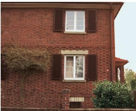
Abb. 35: Backsteinfassade mit sichtbarem Fenstersturz aus Beton
