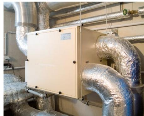
**Abb. 59:** Zu- und Abluftanlage mit Wärmerückgewinnung
