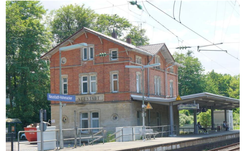
Empfangsgebäude. Denkmalschutz. Keine Fassadensanierung mit Wärmedämmung, nur Dach & Fenster möglich
