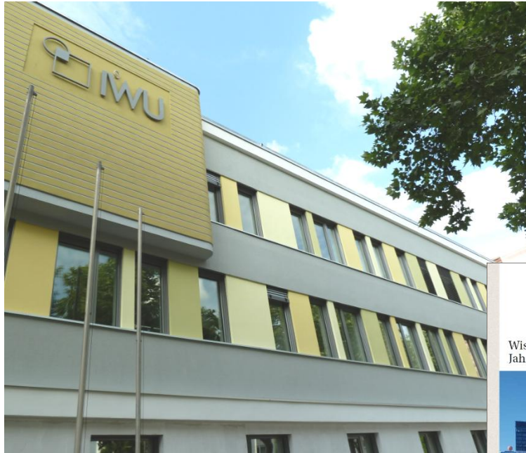
Ansicht des IWU-Hauses nach der Modernisierung mit Passivhaus-Komponenten
