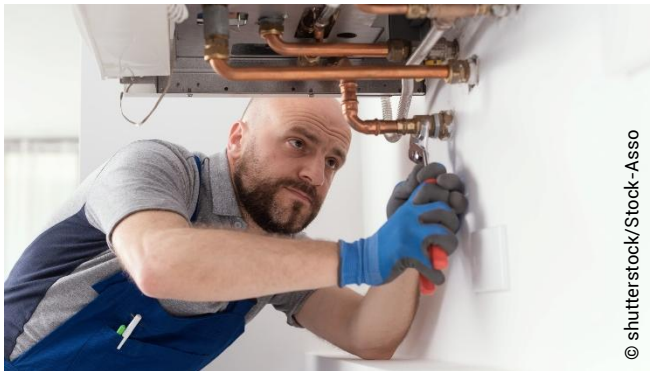
Abbildung 1: Anschluss eines Gas-Brennwertgeräts
