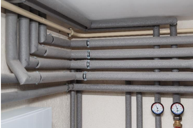
Abbildung: Wenig Aufwand, große Wirkung: Es lohnt sich, Warmwasser- und Heizungsrohre zu dämmen. © shutterstock/Vladeep
