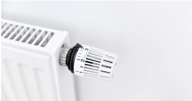
Abbildung: Über das Thermostatventil wird die Raumtemperatur reguliert. © shutterstock /Robert Kneschke
