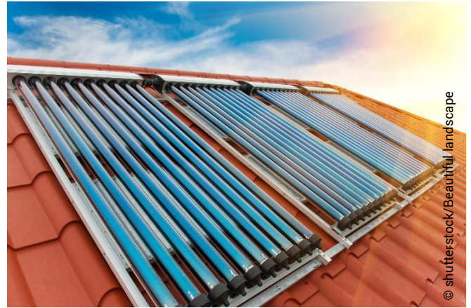
Abbildung 2: Indirekt durchströmte Vakuumröhrenkollektoren (Heatpipe)
